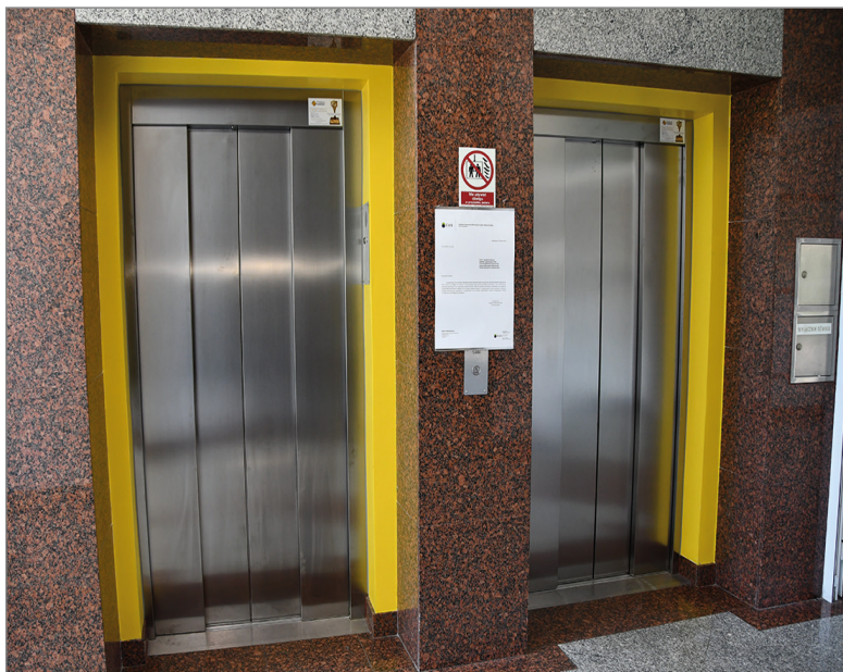
Dostępność architektoniczna w budynku GUS. Oznakowana winda
