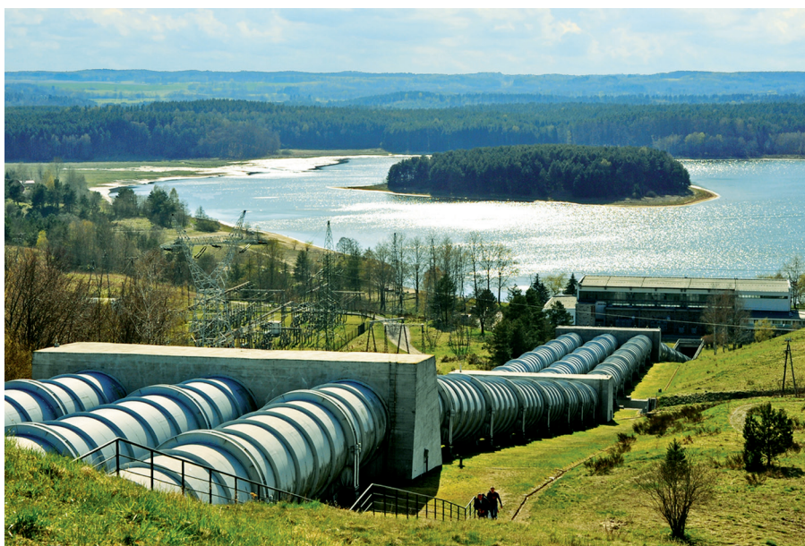
Elektrownia szczytowo-pompowa w Żydowie (fot. Mirela Gałka)
