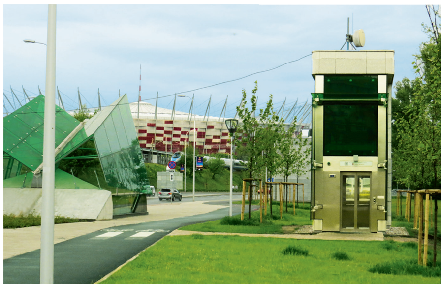
Stacja drugiej linii metra przy Stadionie Narodowym (fot. Robert Chmielewski)
