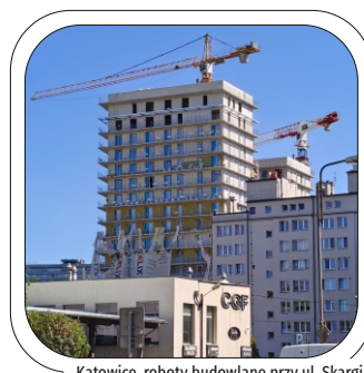
Katowice, roboty budowlane przy ul. Skargi Katowice, construction site on Skargi street
