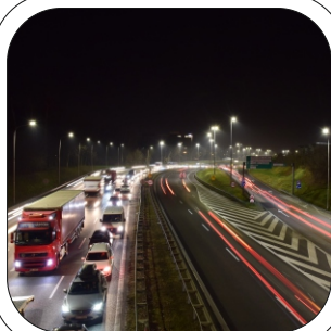
Katowice, Autostrada A4 Katowice, A4 motorway
